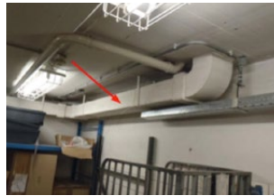
asbestcement luchtkanalen
