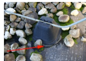
bitumen onder afstandhouder bliksemgeleiding
