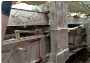
tussen de kanalen is koordpakking toegepast
