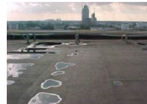
bitumen op plat dak (oude laag)
