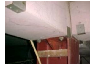
beplating tegen H-balk (staalconstructie)
