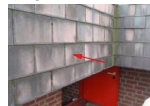
leien tegen de dakrand
