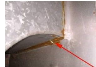
kitafdichting bij metalen luchtkanaal
