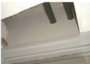
brandcompartimentering (vaak boven verlaagd plafond)
