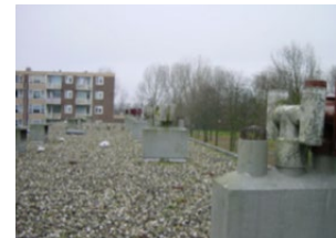
kappen of ontluchting op schoorsteen
