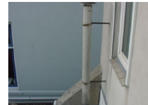
asbestcement hemelwaterafvoer-leiding
